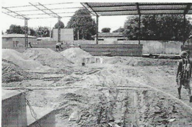
Foto 1 – Início do telhamento, quadra dos Estados
