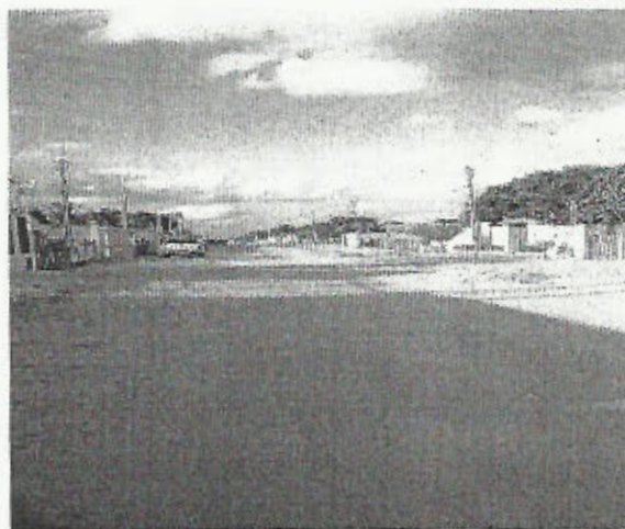
Trecho não asfaltado da Rua Bérnago
