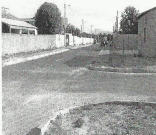
Único trecho asfaltado da Rua Bérnago
