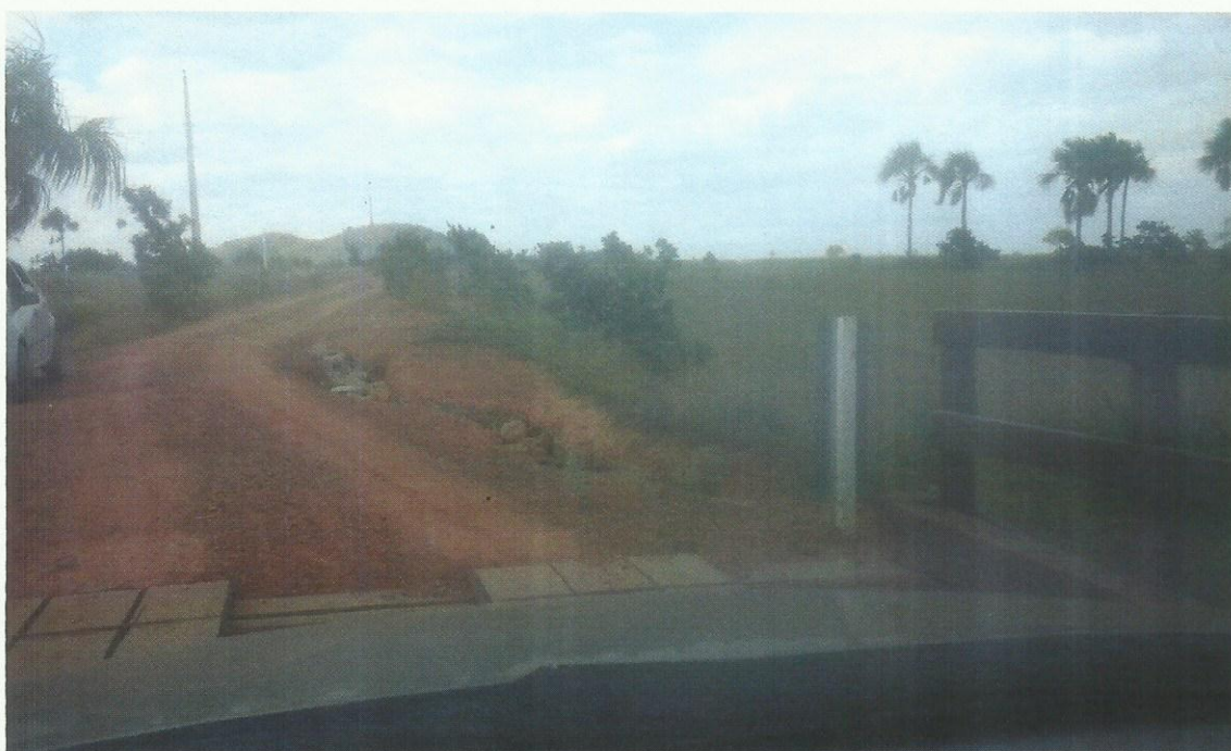
ESTRADA DA COMUNIDADE VISTA NOVA
